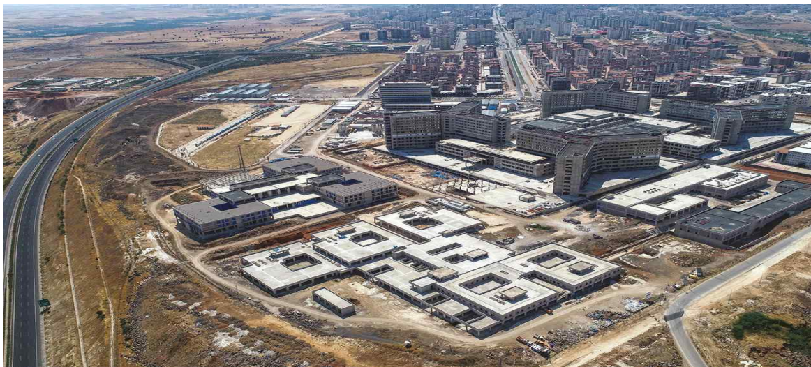
(삼성물산 컨소시엄이 민관협력(PPP) 방식으로 추진 중인 튀르키예 가지안텝 종합병원 공사 현장. /사진=CCN Insaat 출처 : 비즈니스플러스( https://www.businessplus.kr ), 2021.09.16.)
