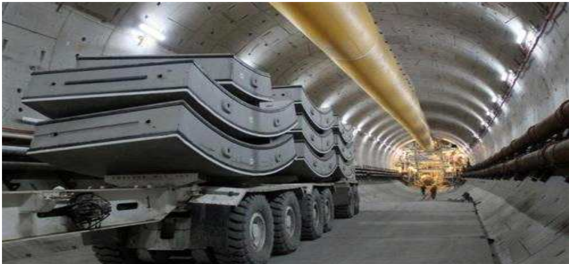
(유라시아 해저터널 콘크리트 벽체 세그먼트 운반, 이투데이 2016.08.10.)
